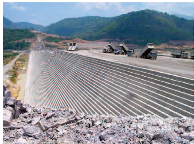
การนำถ่านลิกไนต์โรงไฟฟ้าแม่เมาะไปใช้ในงานก่อสร้างเขื่อนคอนกรีตบดอัดที่เขื่อนคลองท่าด่าน
